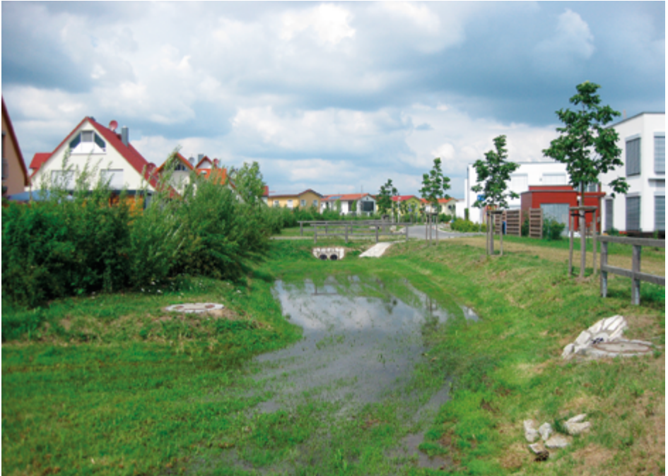
Abb. 70: Überflutungsmulde in Erlangen in einem Wohngebiet
